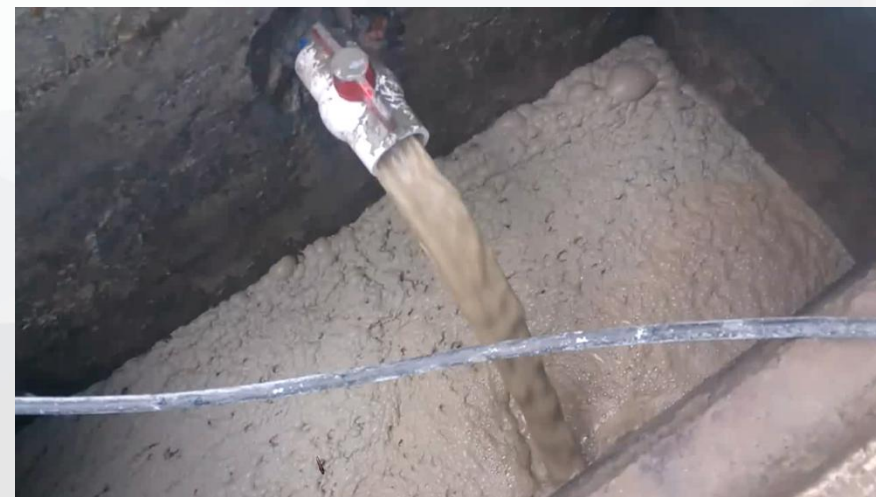
▲ 设备排渣情况
