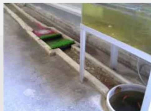
写真6：人工芝端材によるスラッジ除去
