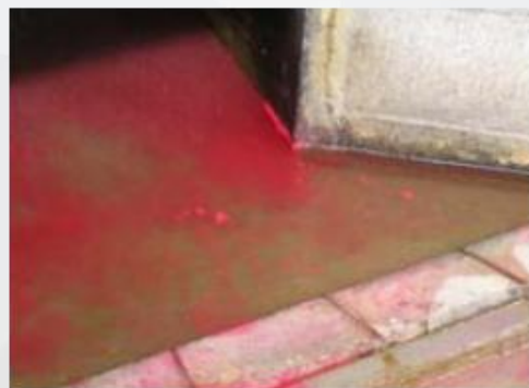
写真5：フード下に浮く塗料スラッジ
